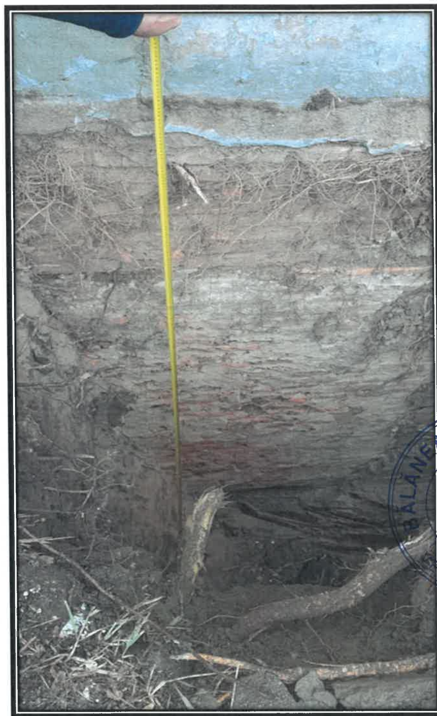
Fig. 24 – Sondaj S1- Dezvelire de fundație corp C1 - SECȚIA DE REUMATOLOGIE - C1 ȘI C2 – CASA APOSTOLEANU COD VN – II – m – B - 06426, Municipiul Focșani, județul Vrancea.
